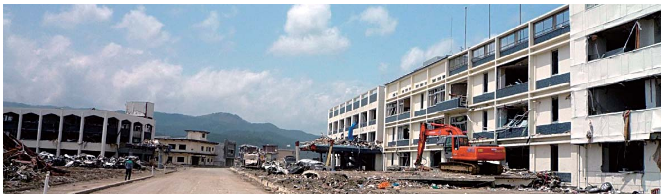
破壊された市庁舎
